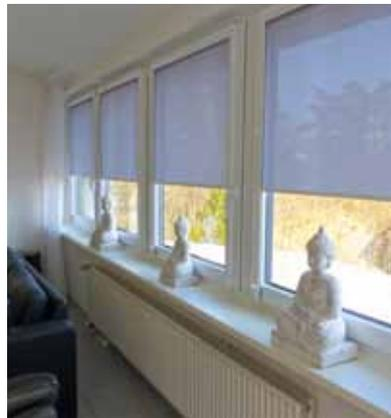
Die Rollos sind fest an den Glasleisten des Fensters montiert und können zusammen gedreht und gekippt werden. Da es seitlich in Führungsschienen gehalten wird, flattert es auch nicht im Windzug. Die Führungen schließen auf der Innenseite des Raumes flächenbündig mit dem Fensterflügel ab, so dass das Rollo Teil des Fensters wird. Die Bedienungskette lässt sich in jeder Position einrasten, kann aber auch über einen Motor erfolgen.
