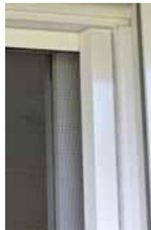
Hier können beide Rollos einzeln bewegt werden und schließen mit dem Magnetverschluß in der Mitte. So werden Öffnungsbreiten bis 2,80 m bei voller Lüftung sicher geschützt. Die Rollokassetten befinden sich sowohl links als auch rechts, um beide Rollos aufzunehmen. Der Einbau von seitlich geführten Insektenschutz-Rollos ist bei Terrassentür-Anlagen oft auch dann noch nachträglich möglich, wenn Außenrollläden vorhanden sind.
