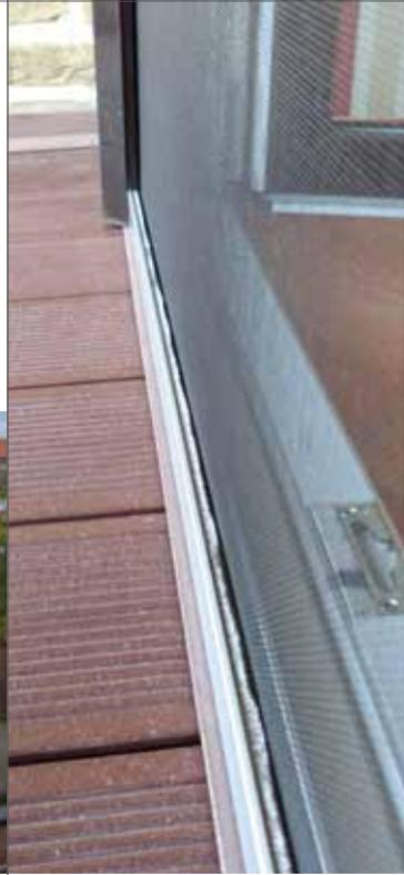
Die stabilen Aluminiumprofile sind standardmäßig in weiß und braun erhältlich – auf Wunsch auch in allen RAL-Farben. Der nachträgliche Einbau von seitlich geführten Insektenschutz-Rollos ist bei Terrassentür-Anlagen oft auch dann noch möglich, wenn Aussenrollläden vorhanden sind.
